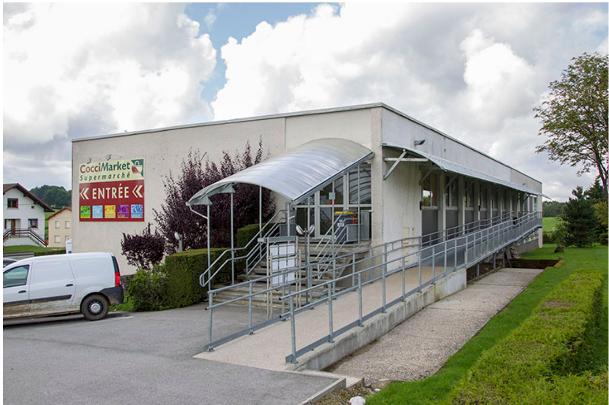
Façades latérale droite et postérieure.
