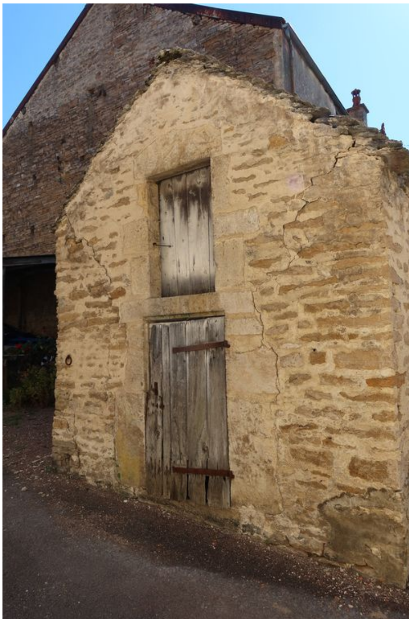
Détail de l'élévation ouest de la construction.
