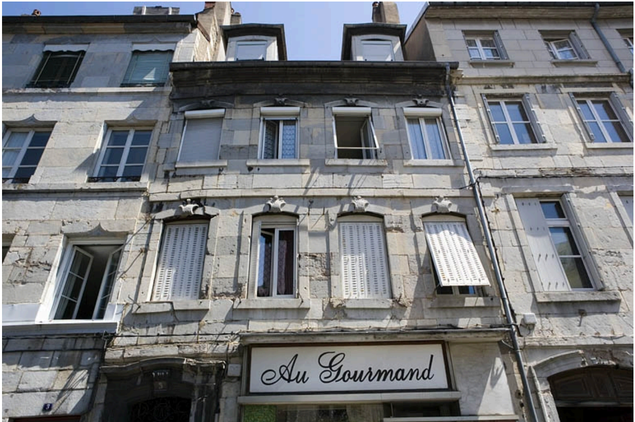
Vue rapprochée de la façade sur rue, de face.
