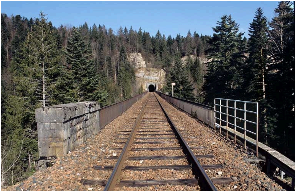
Viaduc et tunnel : vue d'ensemble côté La Cluse.
