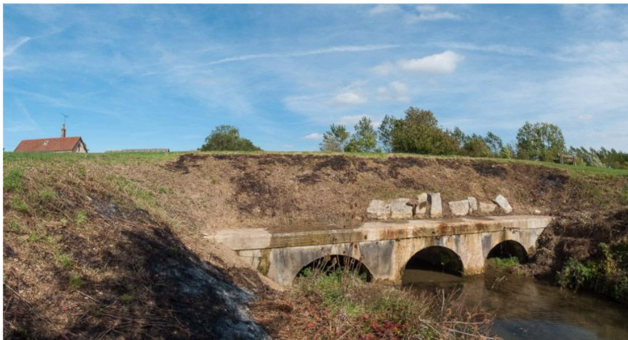
Aqueduc en amont du sas.
