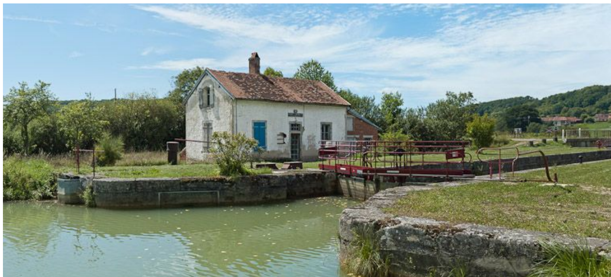
Vue d'ensemble du site d'écluse.
