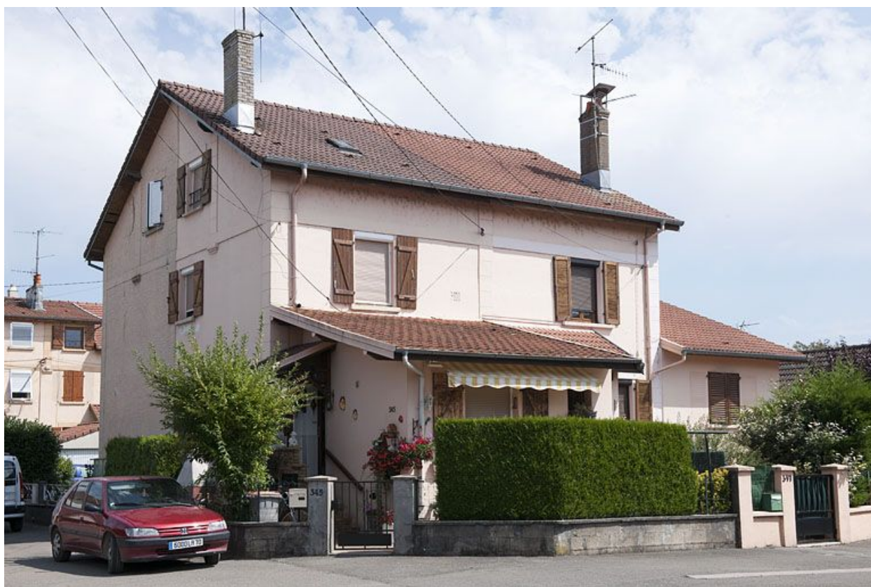
Habitation à 4 logements. Façade ouest.
