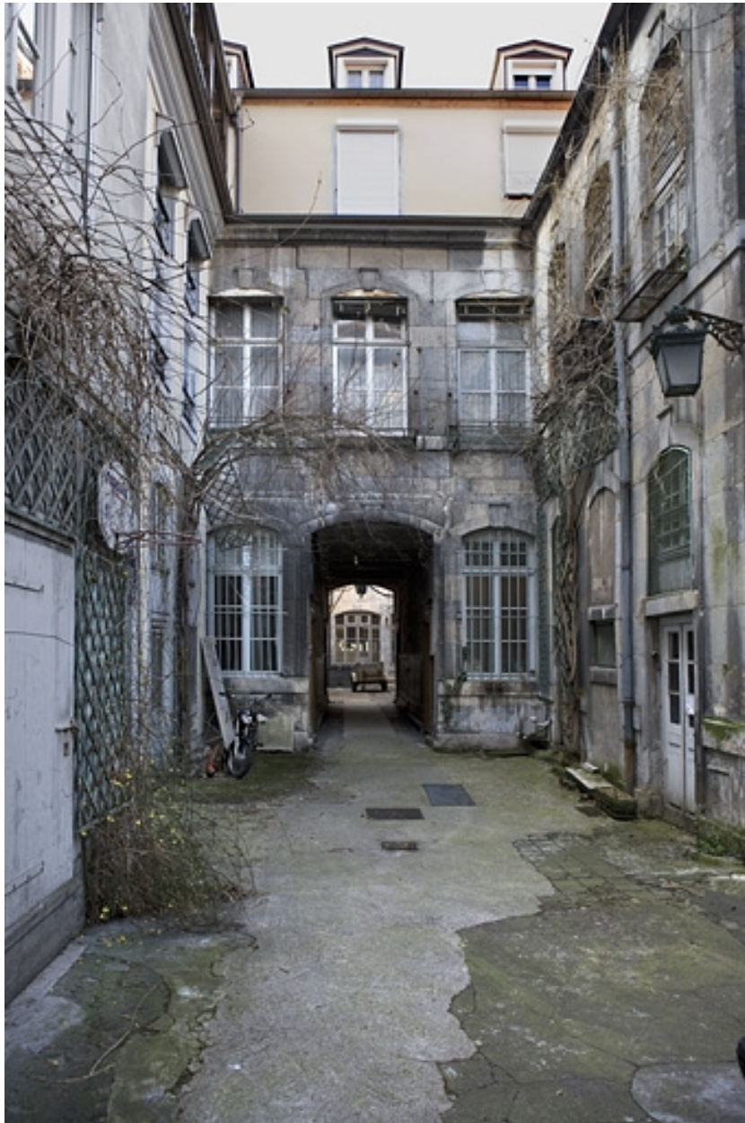
Façade postérieure du premier logis secondaire depuis le fond de la deuxième cour.
