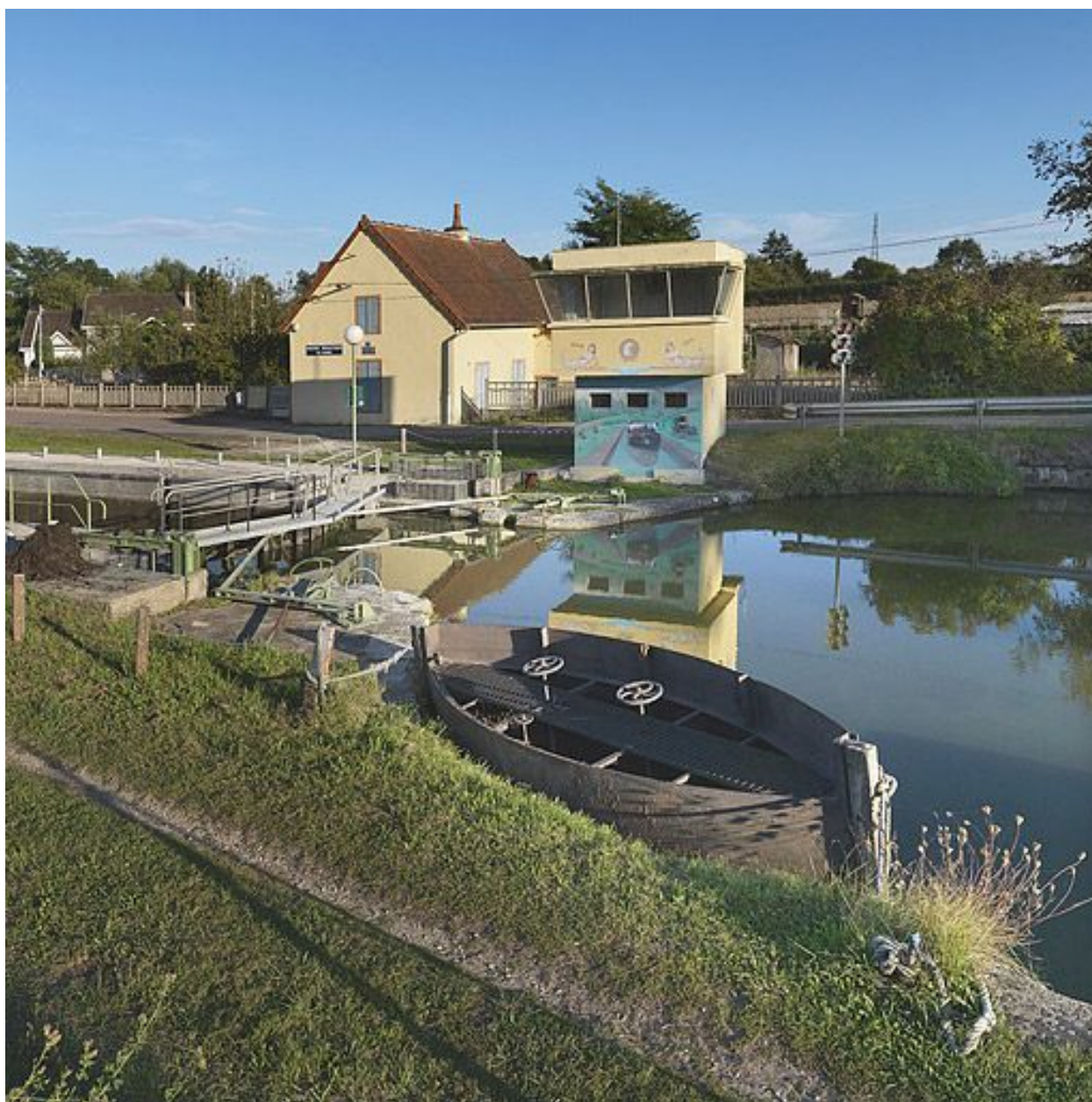
Site d'écluse pris d'amont.
