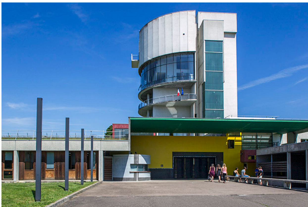
Face à l'entrée et la tour.
