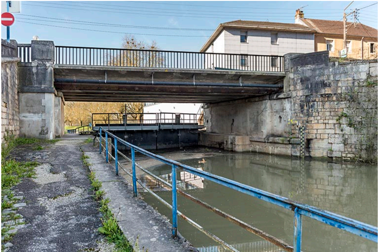
La porte de garde, vue depuis l'amont.
