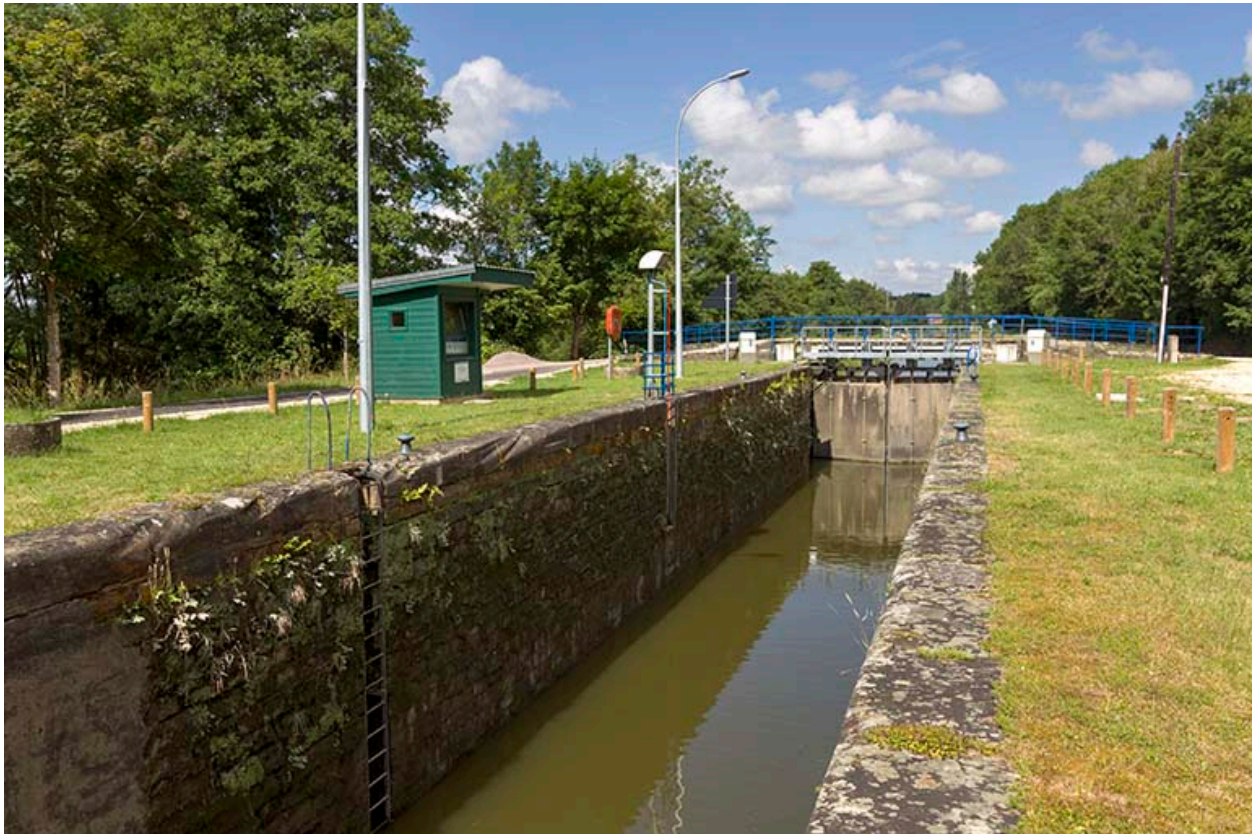
L'écluse et son poste de commande.
