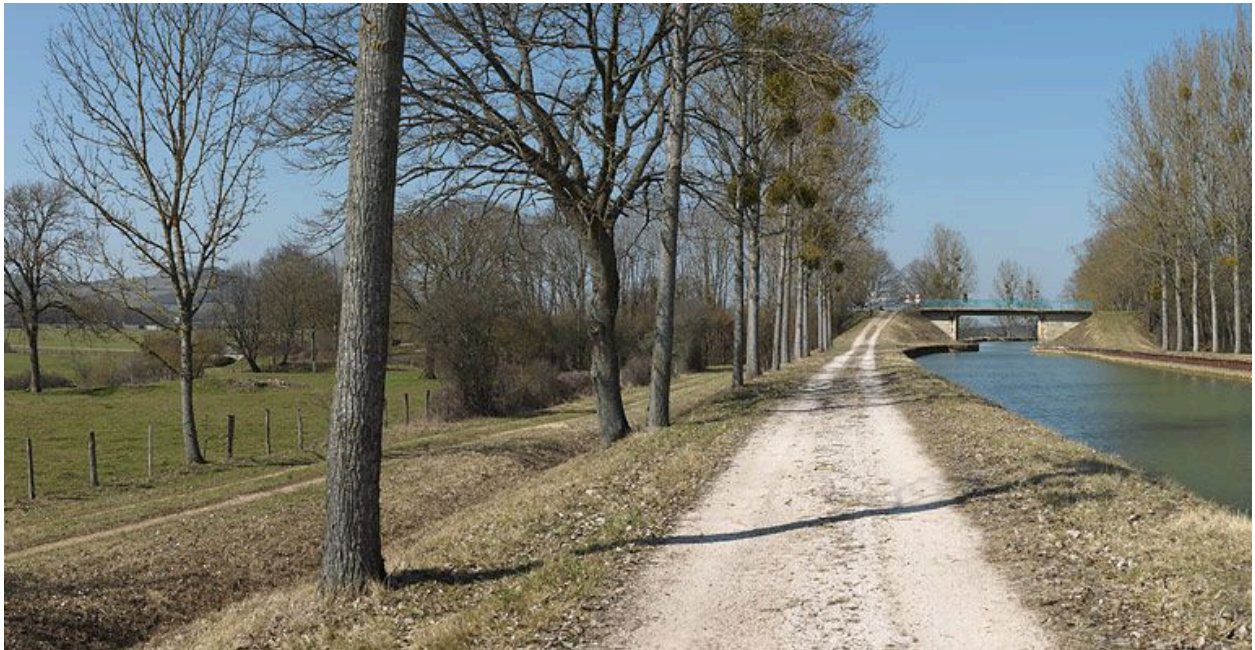
Vue d'ensemble du pont.
