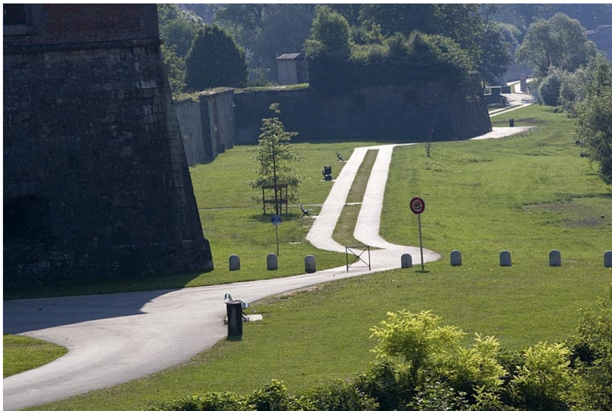
Besançon : le chemin de halage au pied de la courtine de Chamars.
