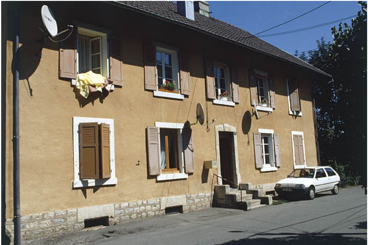
Façade antérieure d'un logement ouvrier à 4 appartements.
