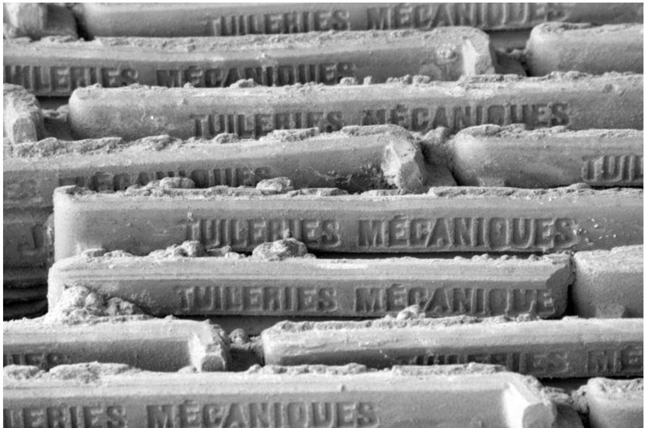
Détail de l'appareil de tuiles en gros-oeuvre.
