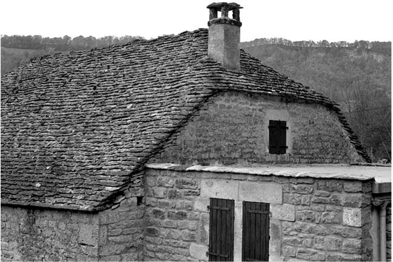
Détail d'une toiture en laves.
