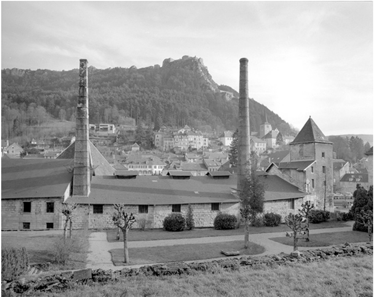
Façade ouest de la salle des poêles (1993).
