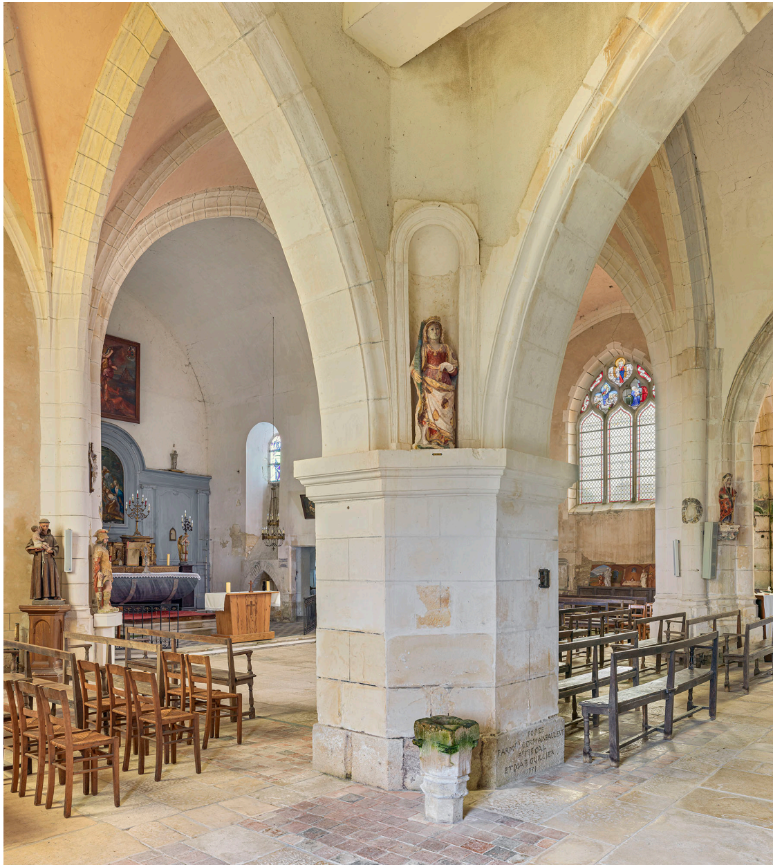
Le chœur vu depuis le transept nord.
