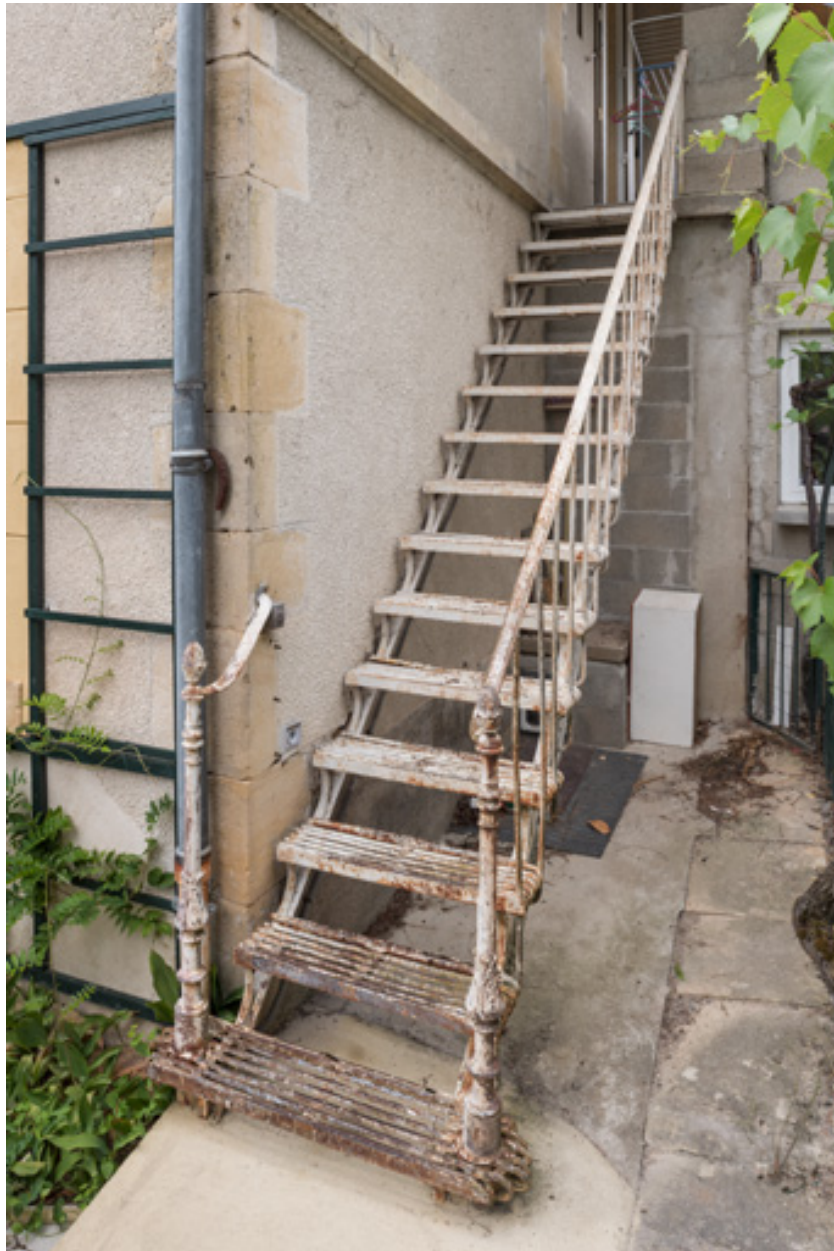
Escalier extérieur conduisant à l'étage.
