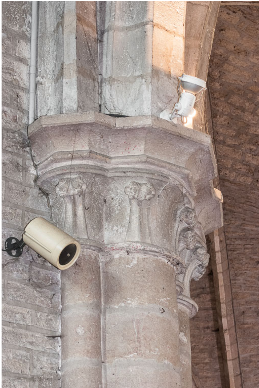
Vue d'un chapiteau d'un pilier de la croisée.
