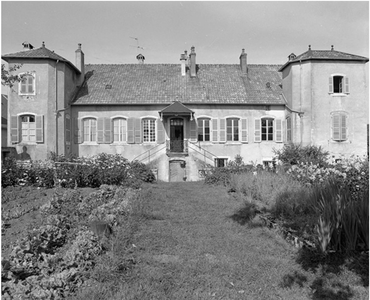
Façade antérieure, vue de face.
