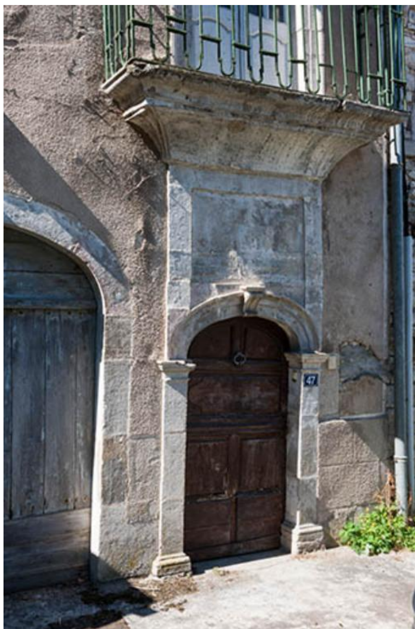
Porte du 47 Grande Rue
