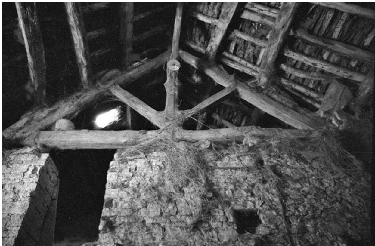
Ferme cadastrée 1960 B 109, située au lieudit La Peyrouse : charpente de toit de laves.
