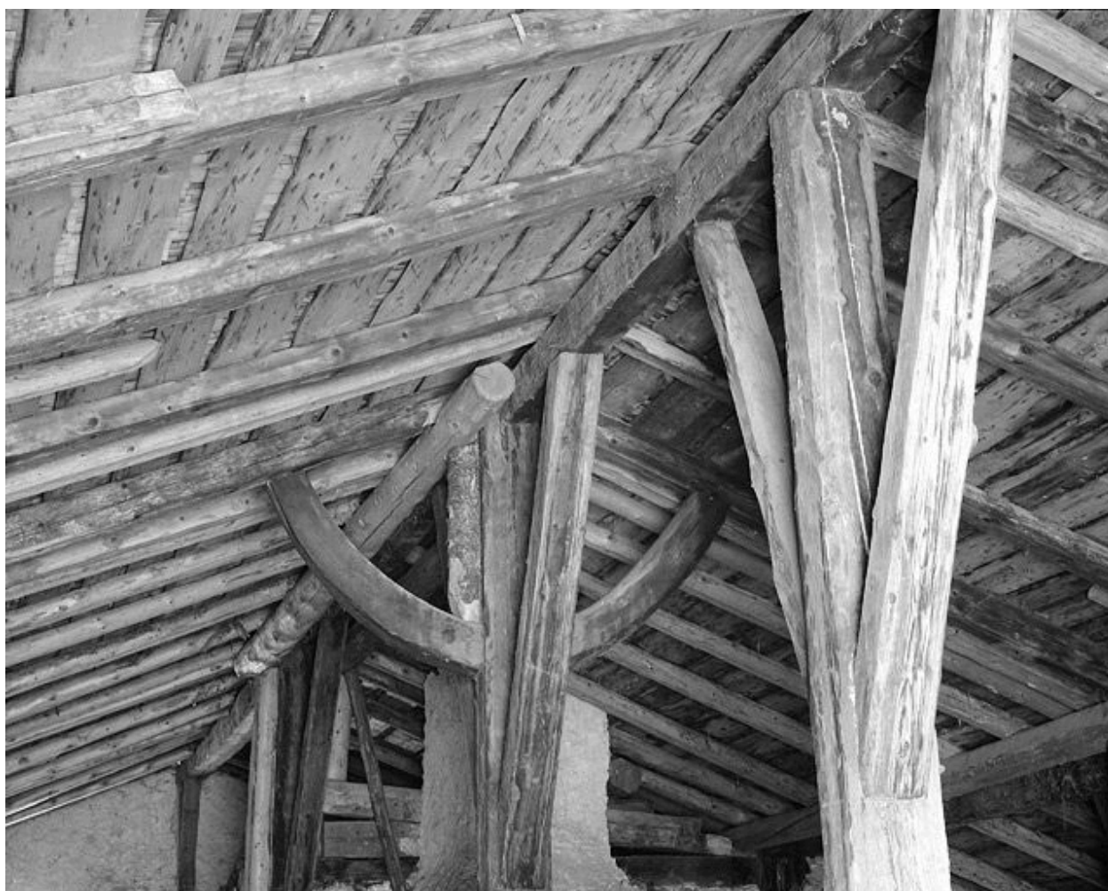
Charpente, colonne sous faîtage et contrefiche.
