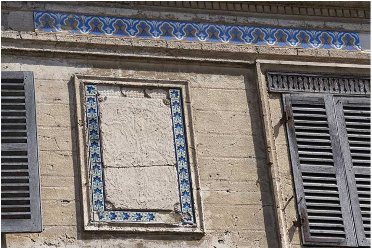
Détail de décor polychrome en céramique sur la façade.
