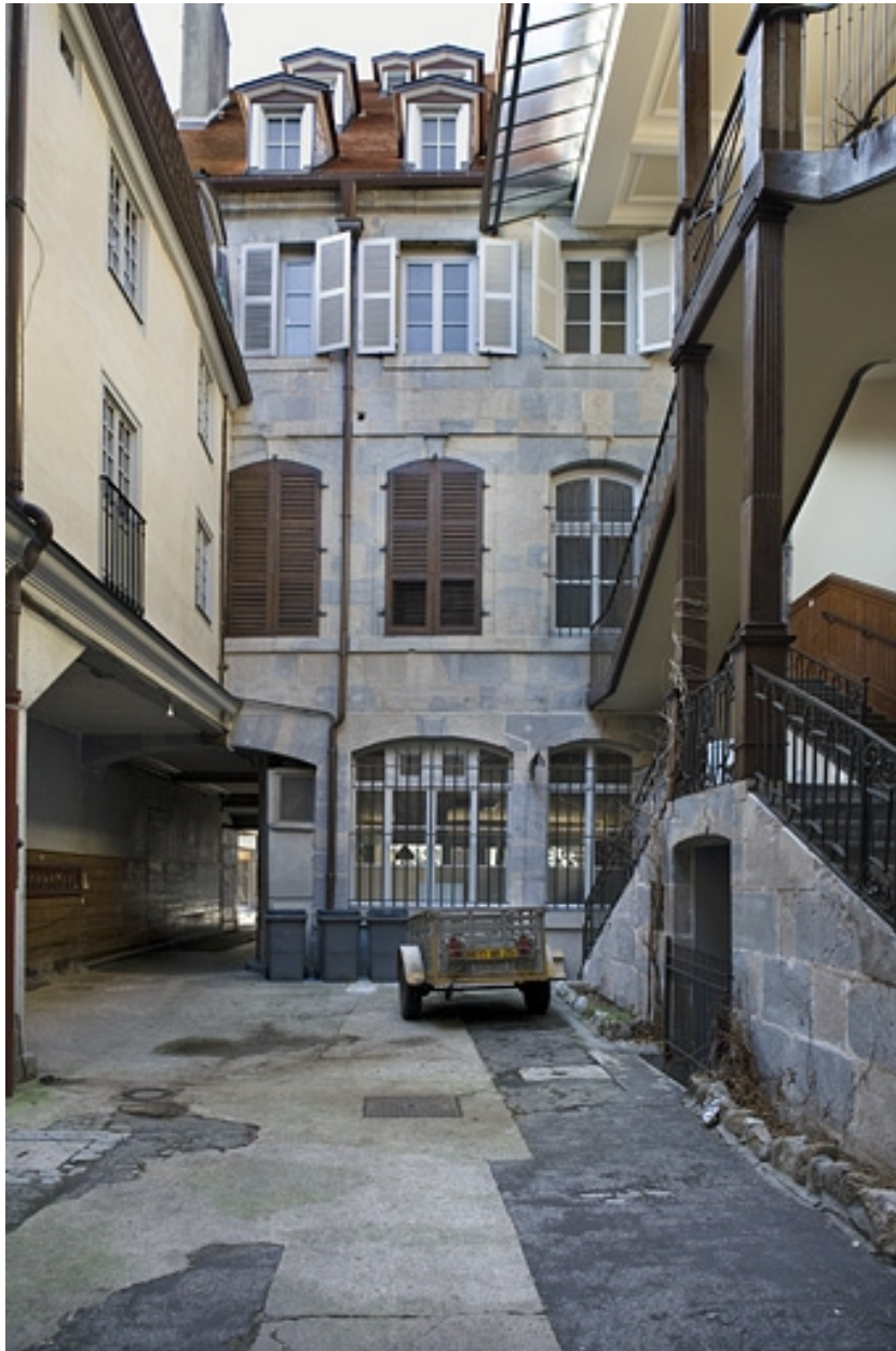
Façade postérieure du logis principal depuis le fond de la première cour.
