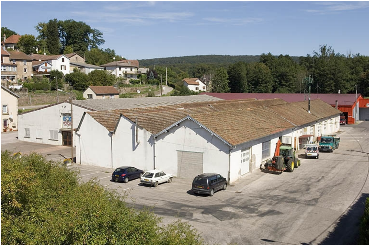
Vue depuis le sud-ouest.
