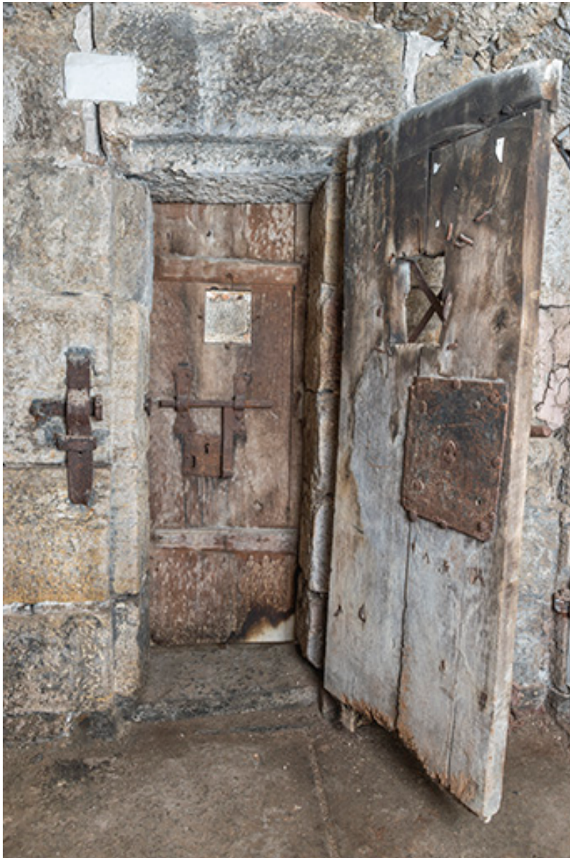
Portes doubles d'une cellule.
