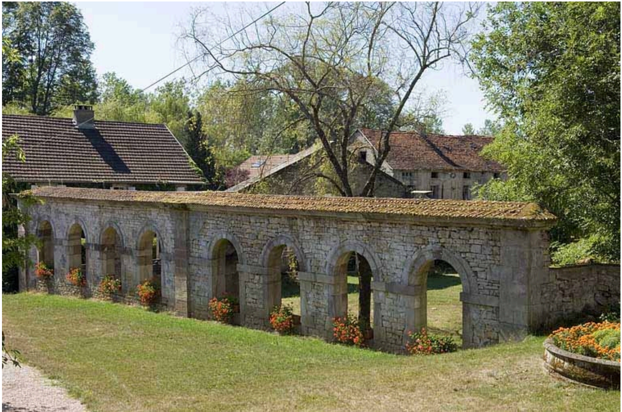
Vestiges de l'atelier de fabrication. Mur nord.
