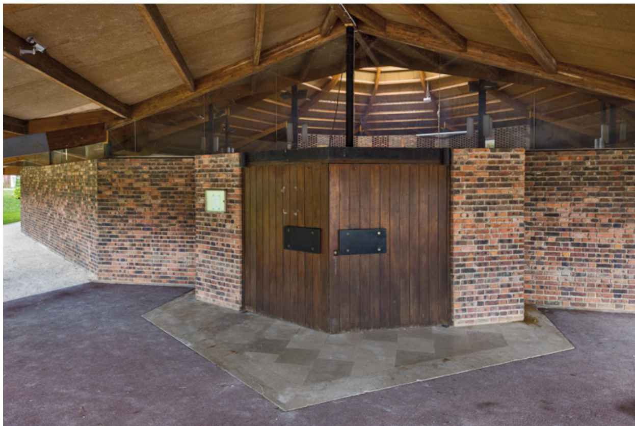
Eglise. Détail de l'entrée principale.
