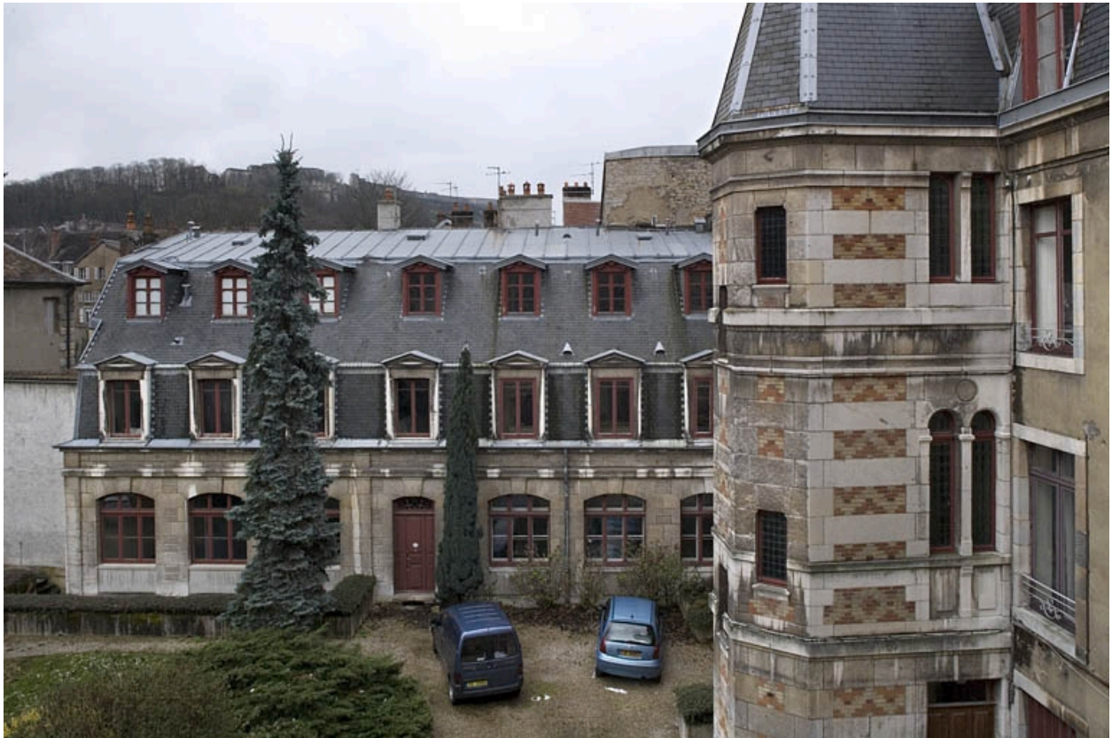
Vue d'ensemble de l'aile droite sur cour, de face.
