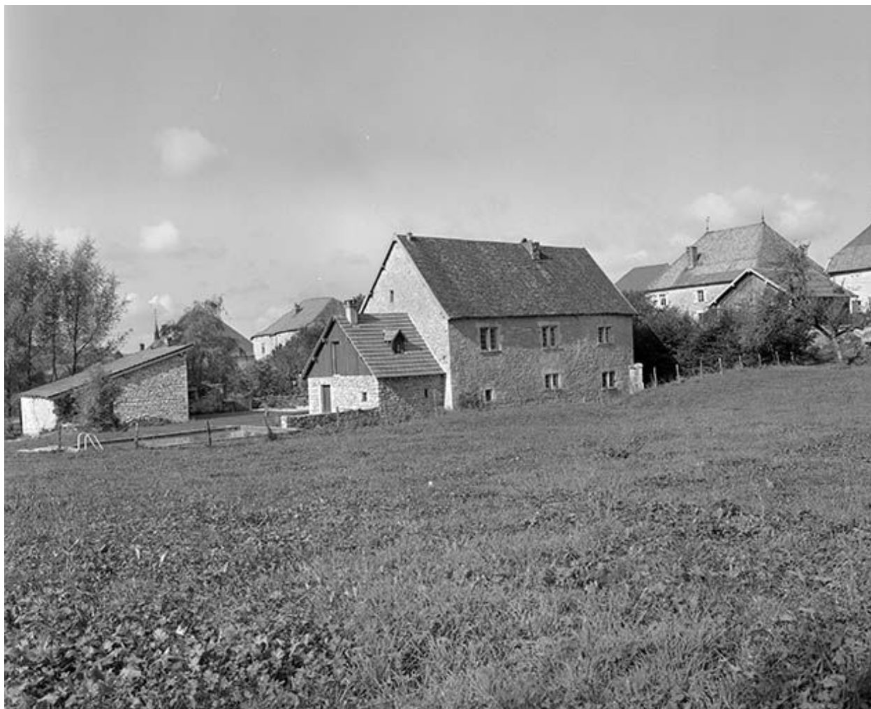
Façade postérieure vue depuis le pré.
