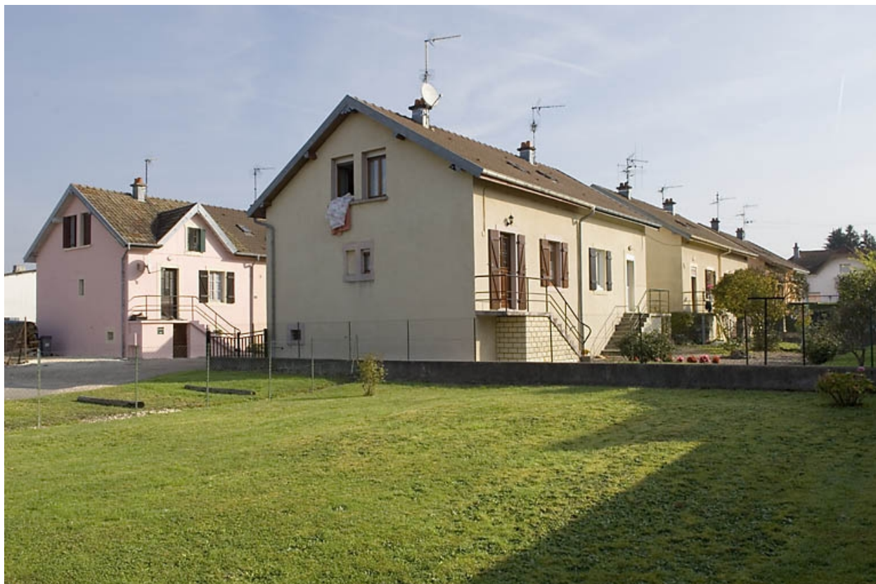
Ensemble de logements doubles.
