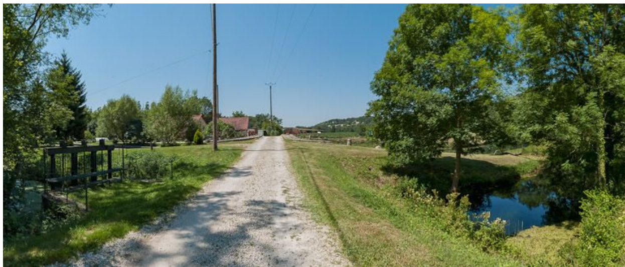
Arrivée de la rigole et vannes à gauche.
