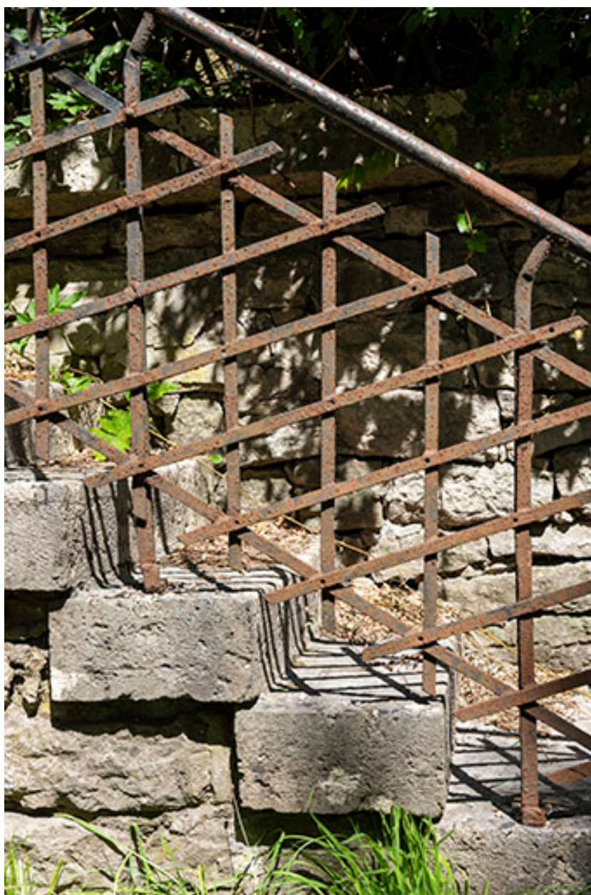
Garde-corps de l'escalier indépendant.
