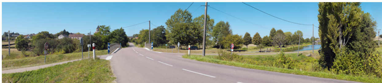
Pont sur l'écluse 03.
