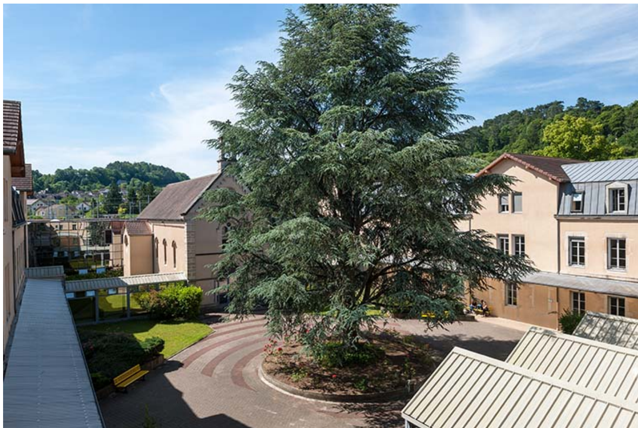
Vue de la cour intérieure
