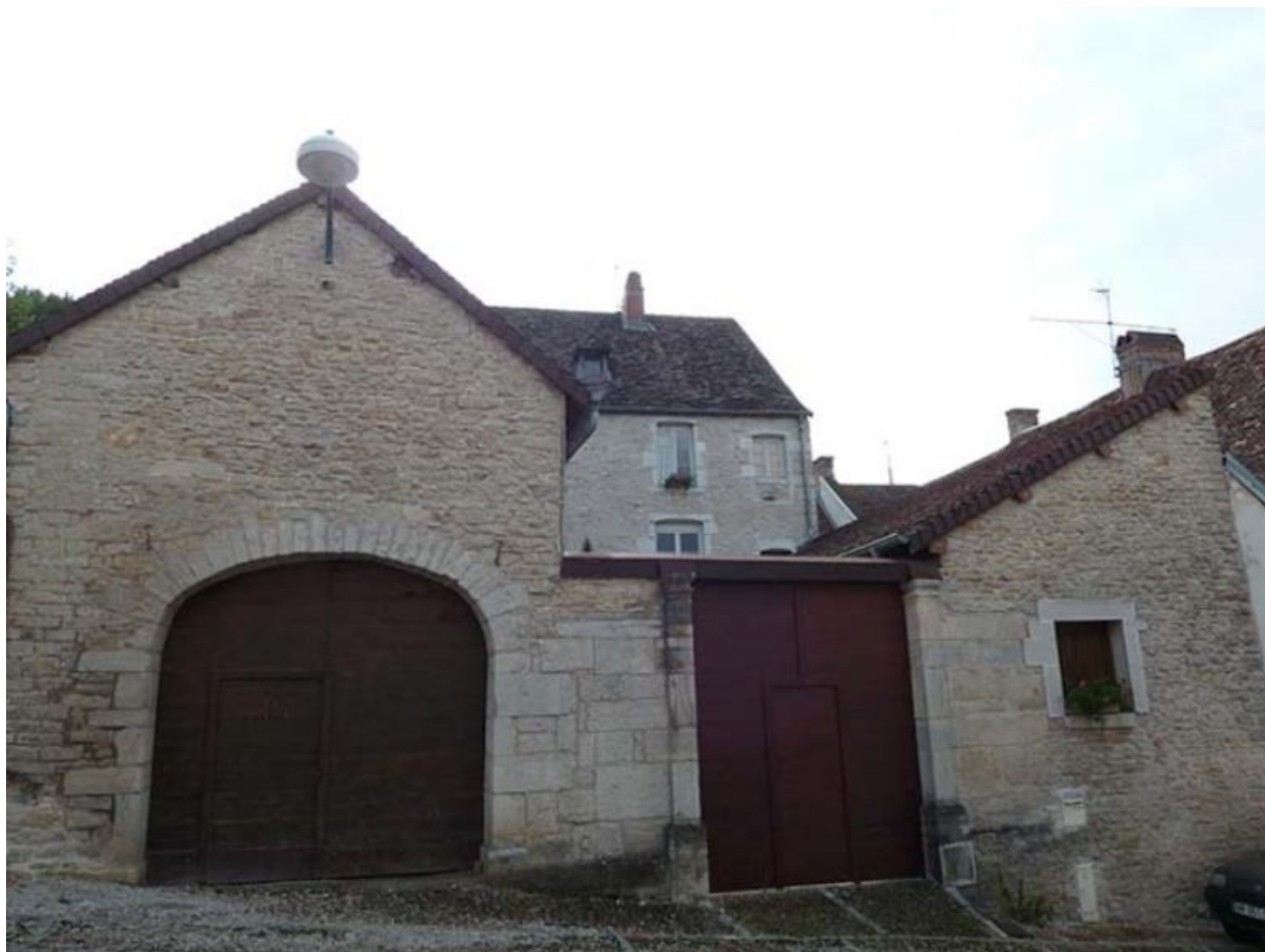
Vue générale Est
