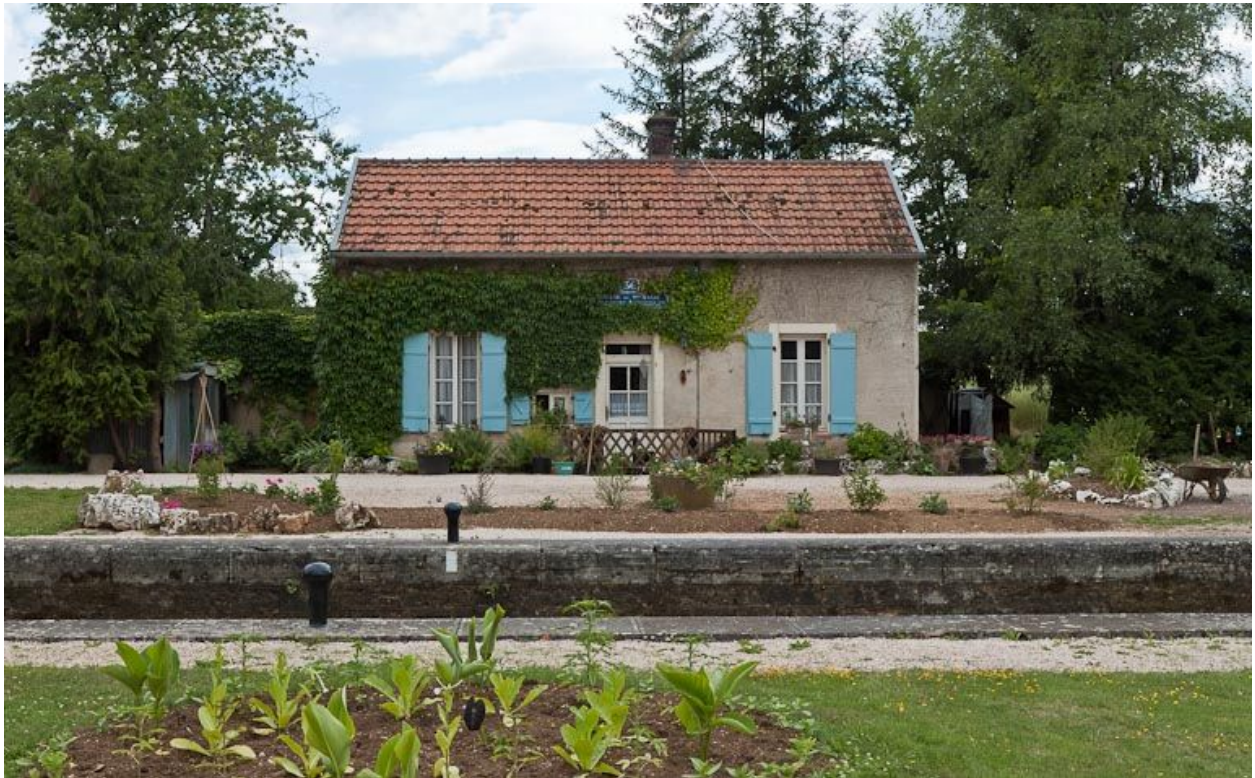
Vue de face de la maison éclusière.
