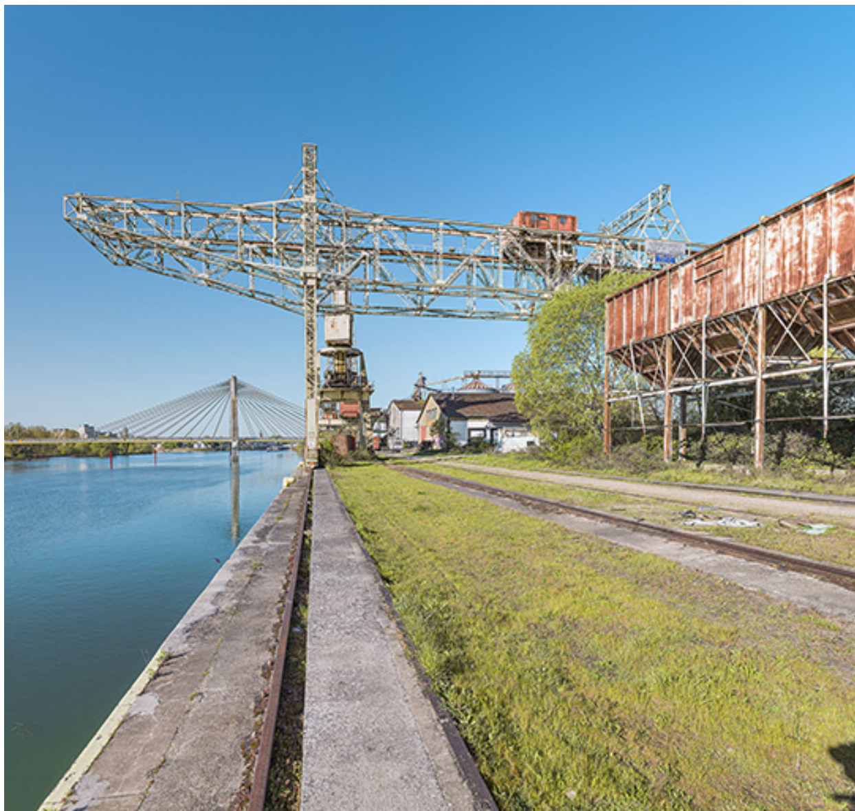
Pont-portique et trémies, le long du quai.
