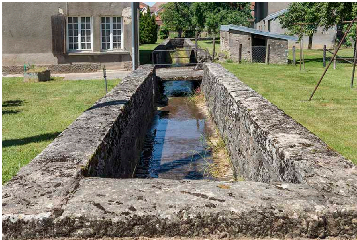
Le ruisseau canalisé qui traverse le village.
