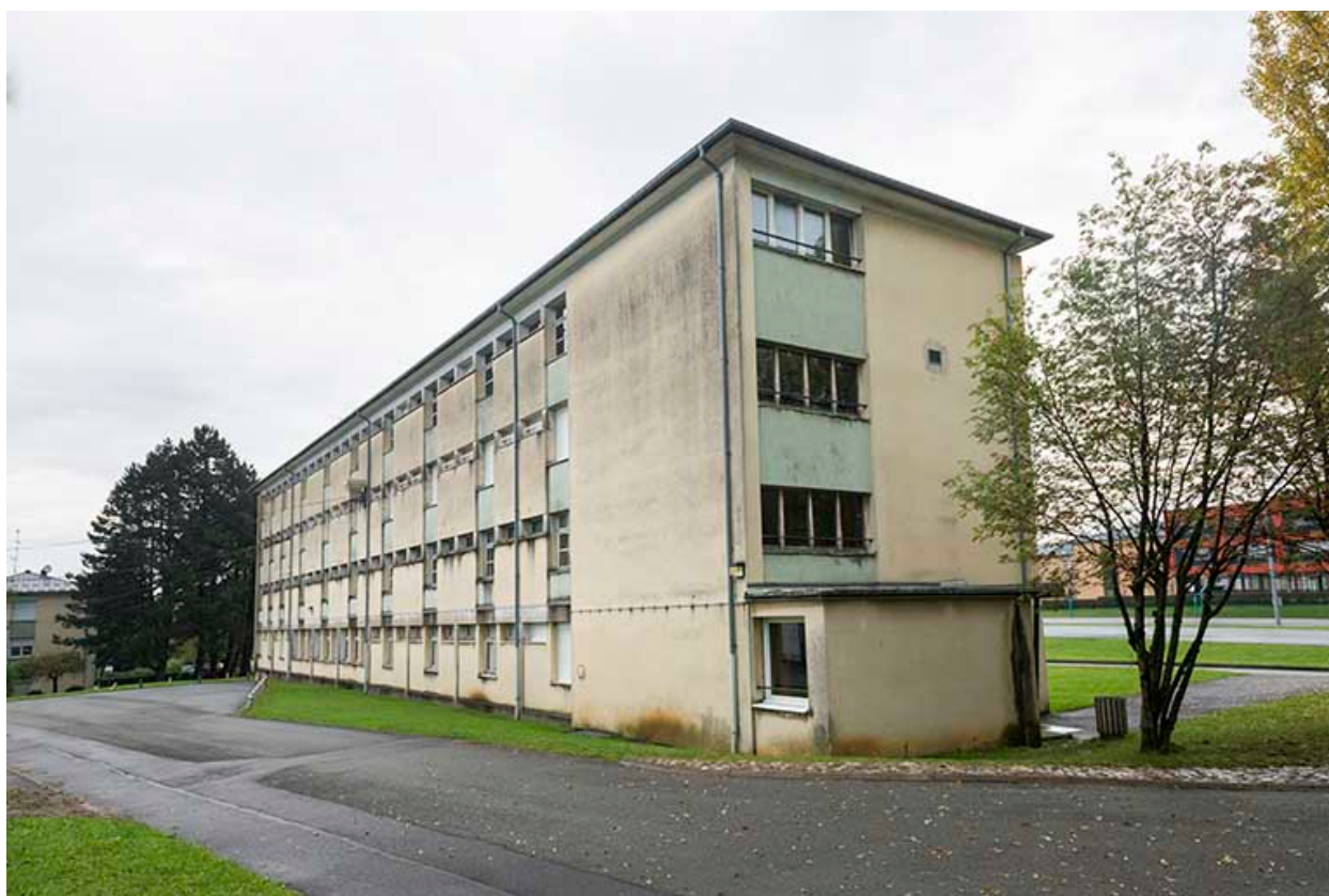
Angle sud-ouest de l'internat de garçons ouest.
