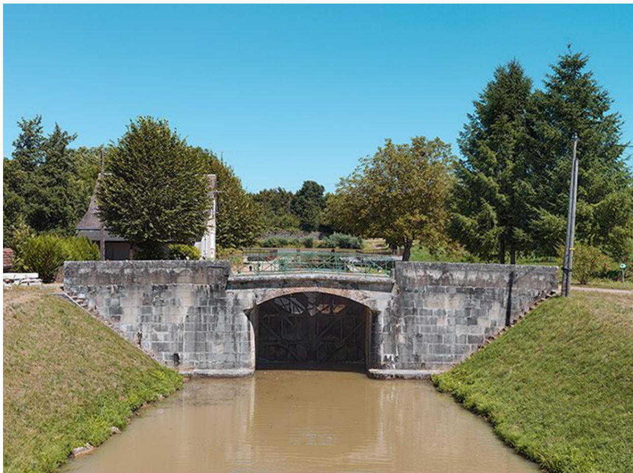
Vue d'ensemble du pont.
