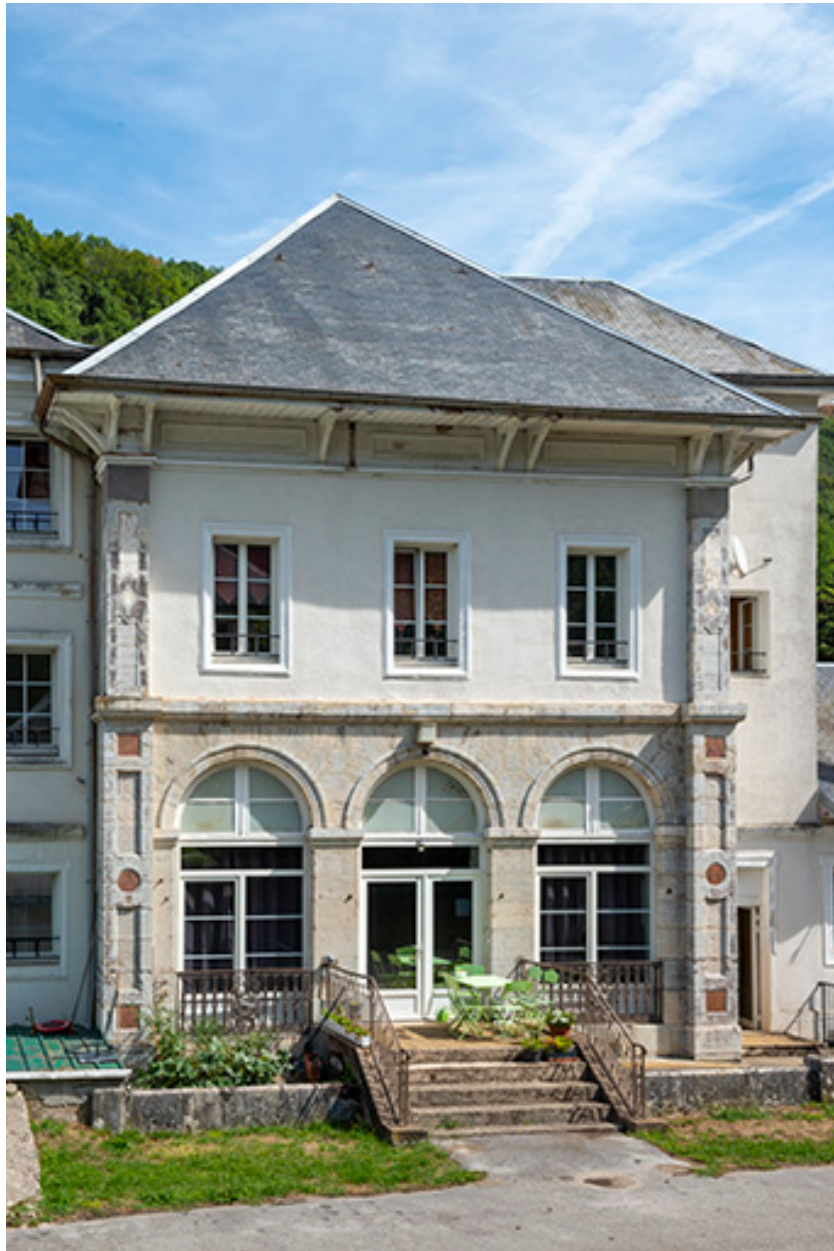
Façade arrière, vue de trois quarts, détail : avant-corps central.
