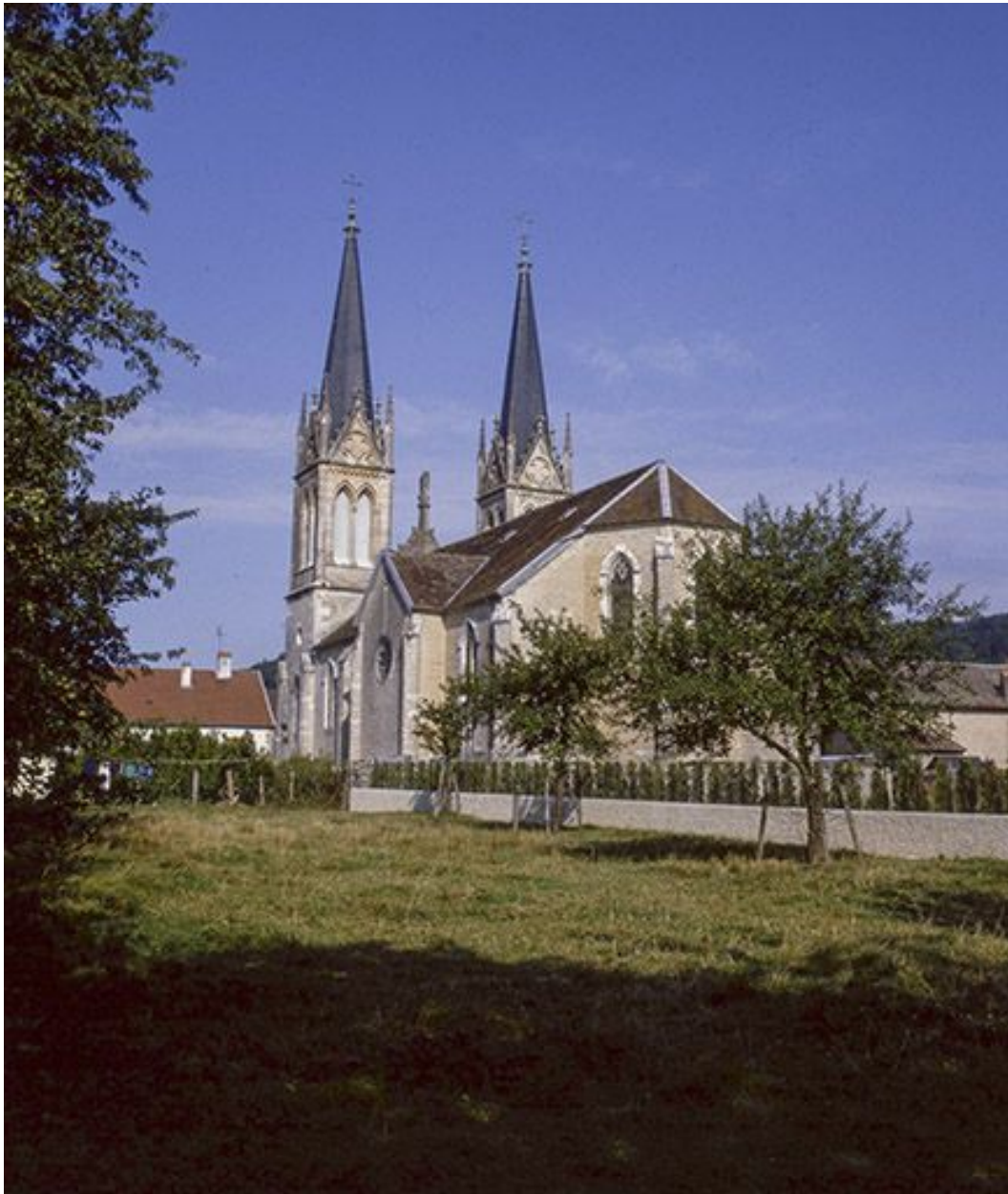
Extérieur : façades postérieure et latérale droite.
