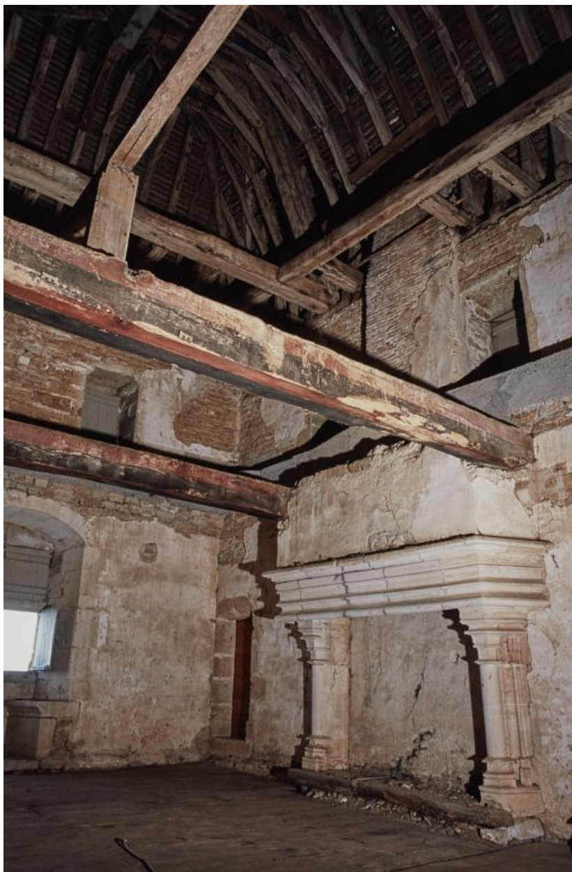
Donjon, le comble avec cheminée.
