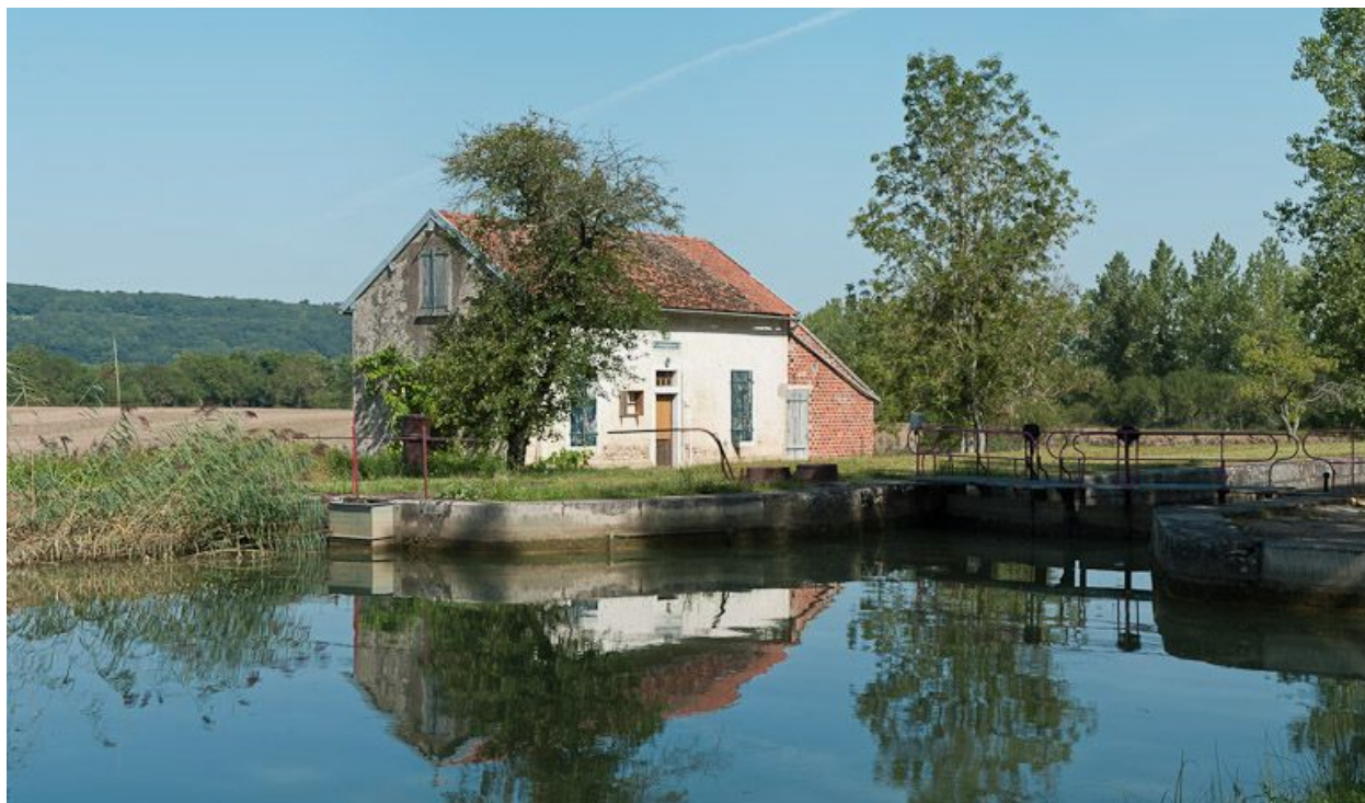
Vue du site d'écluse depuis l'amont.
