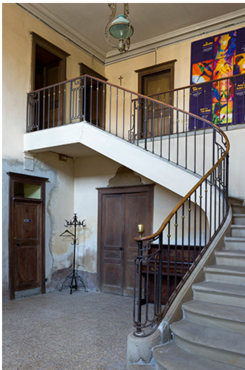
Vue d'ensemble de l'escalier de distribution intérieur.
