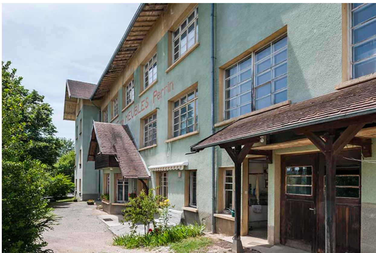
Détail de la façade est.
